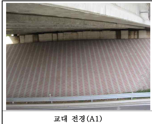
【사진 9.3.8】 교대 전경
