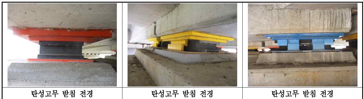
【사진 9.3.12】 교량받침 전경
