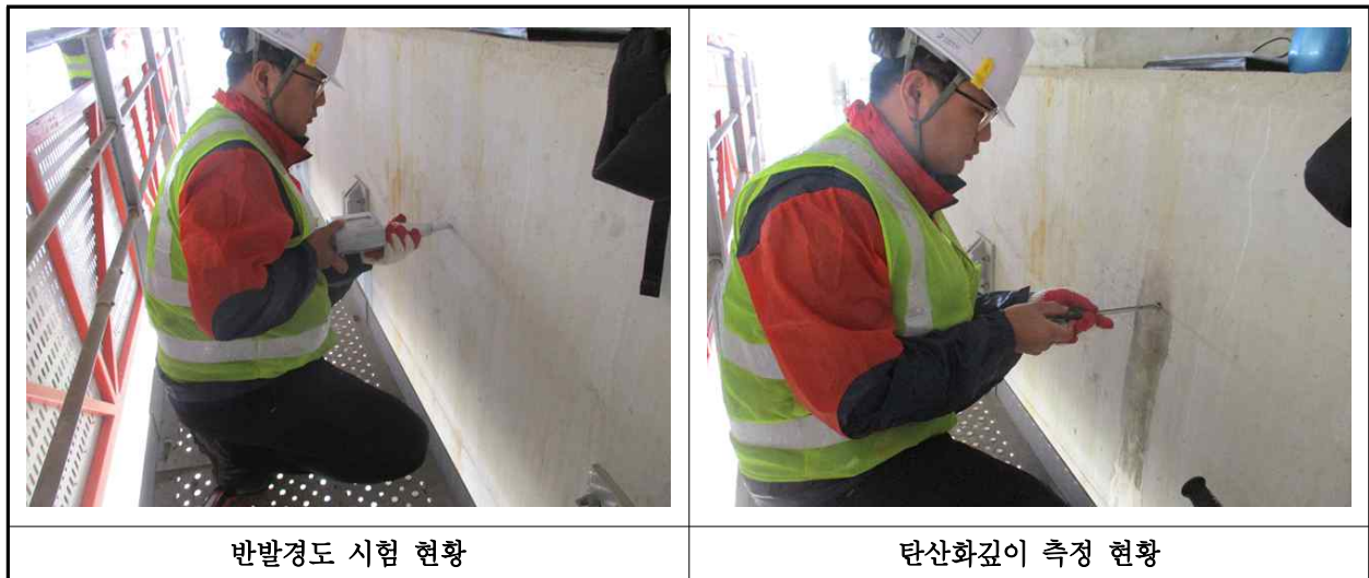
【사진 9.4.1】 콘크리트 내구성조사 현황
