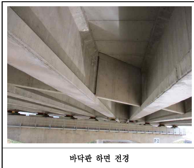
【사진 9.3.2】 바닥판하면 전경
