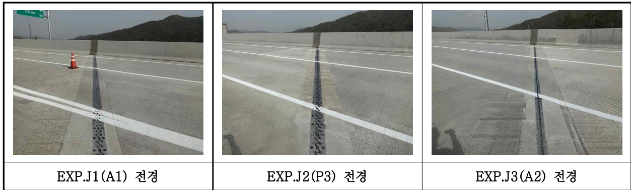
【사진 9.3.16】 신축이음장치 전경
