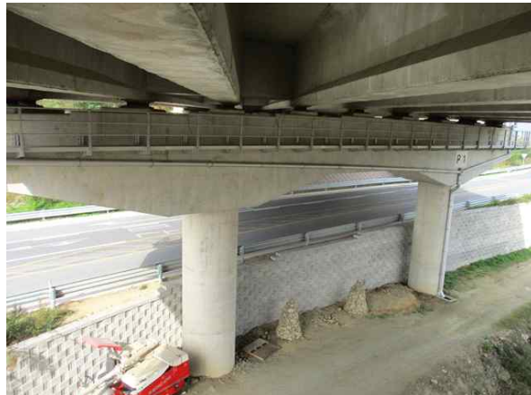
점검로 상태 양호
