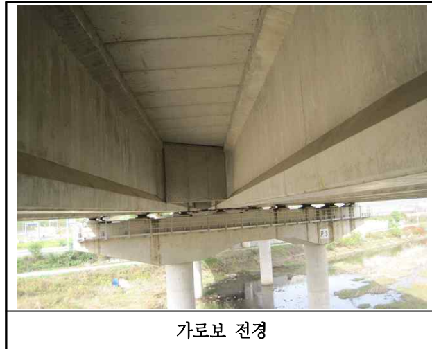
【사진 9.3.6】 가로보 전경
