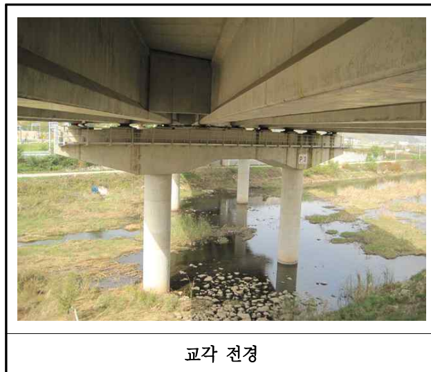
【사진 9.3.10】 교각 전경
