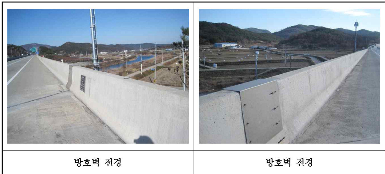
【사진 9.3.22】 방호벽 및 중앙분리대 전경
