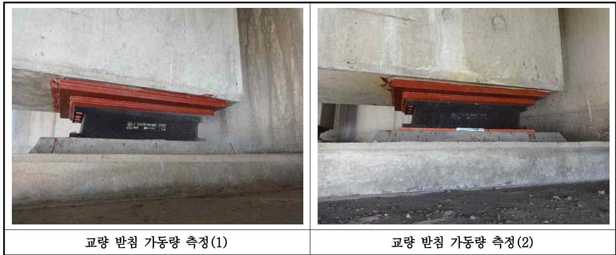
【사진 9.3.15】 교량받침 이동량 측정
