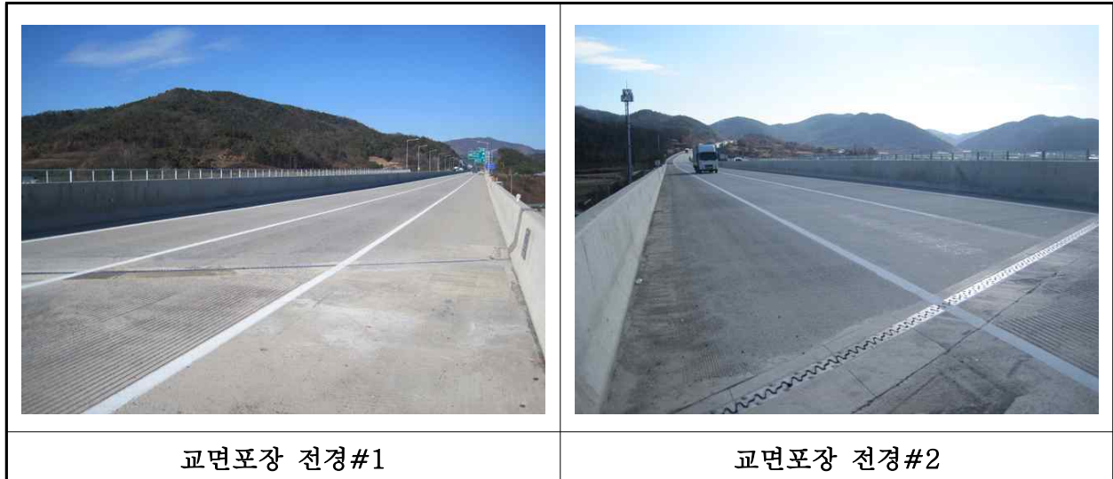
【사진 9.3.19】 교면포장 전경
