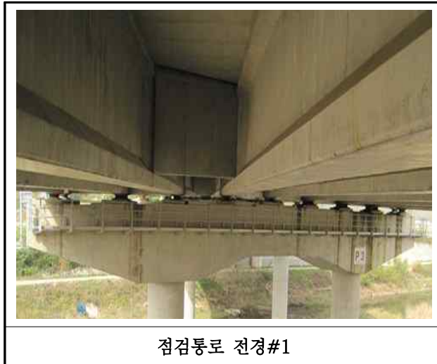
【사진 9.3.24】 교량 점검시설 전경
